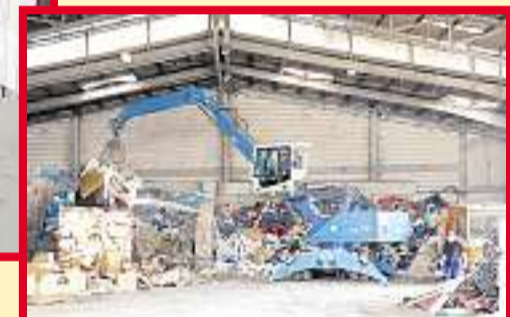
Auch Bauschutt, der mit Hilfe eines Krans sortiert wird, entsorgt die Firma im Ostend.
